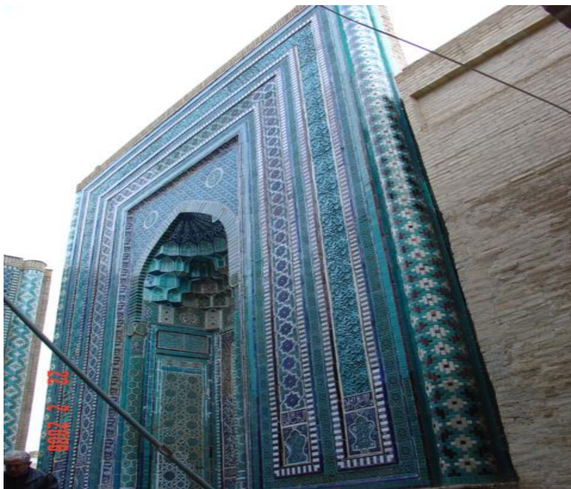
Рис. 9. Состояния главного фасада после ремонтно-восстановительных работ.
