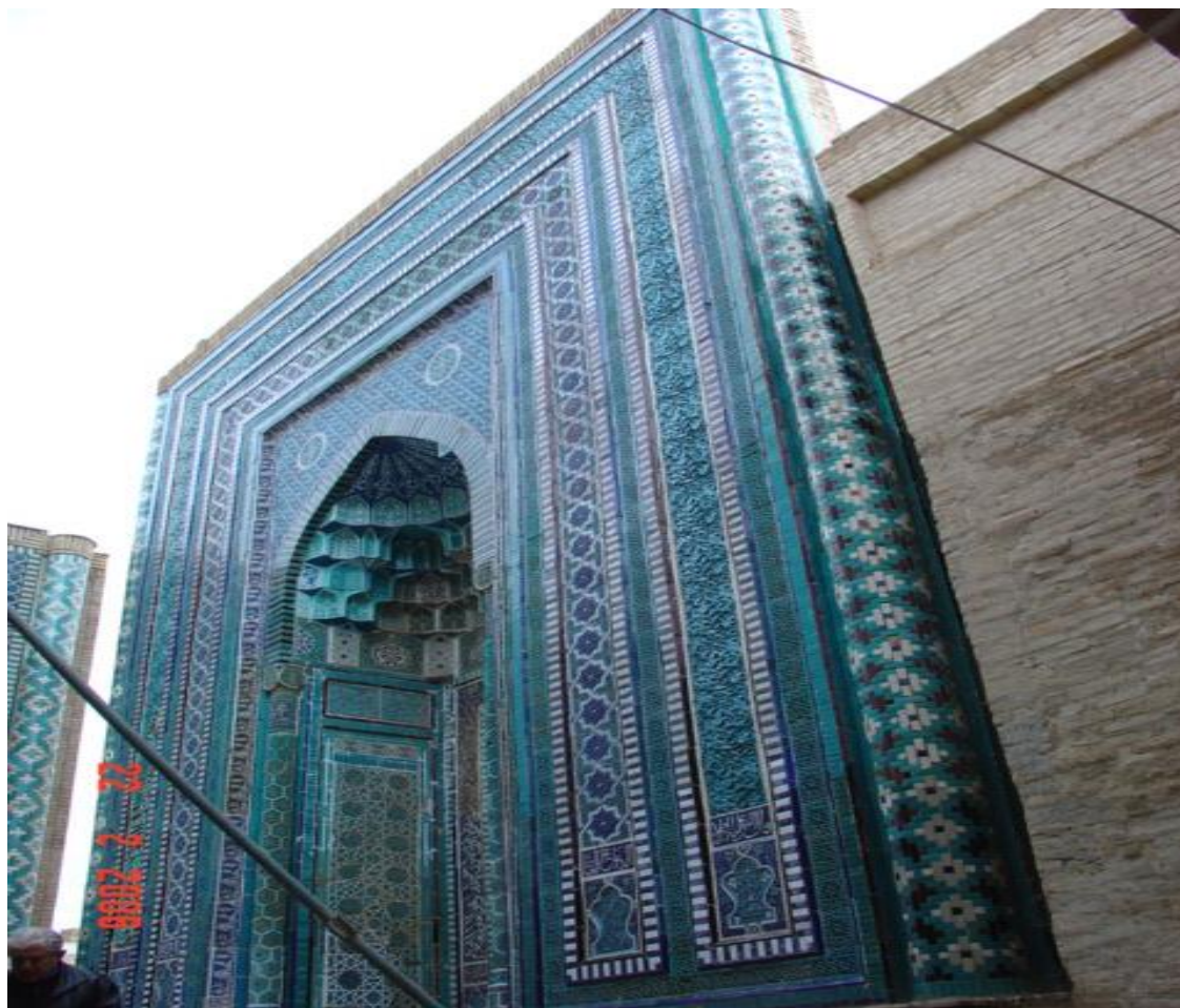
Рис. 9. Состояния главного фасада после ремонтно-восстановительных работ.
