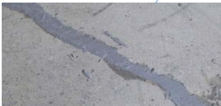
рис. 2. Смесь для ремонта трещин быть наполненным.
