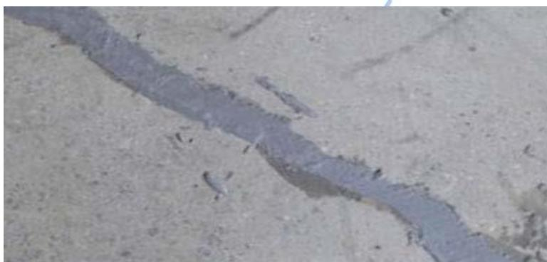
рис. 2. Смесь для ремонта трещин быть наполненным.
