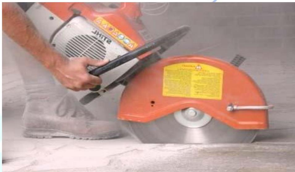
рис. 1. Глубина по периметру минимальна Вырезать на глубину 2 см.
