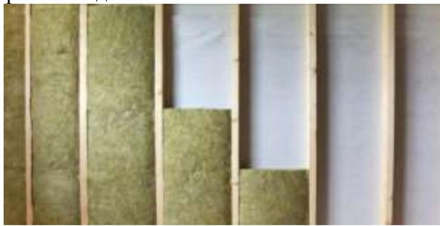
В каркасных домах утеплитель монтируется враспор между стойками каркаса. Поэтому для утепления используют только плитный материал, с достаточной жесткостью
