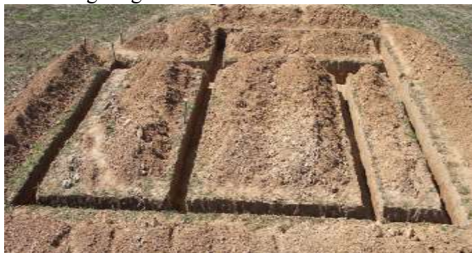
1-rasm. Qolip o‘rnatish uchun asosni tayyorlash
