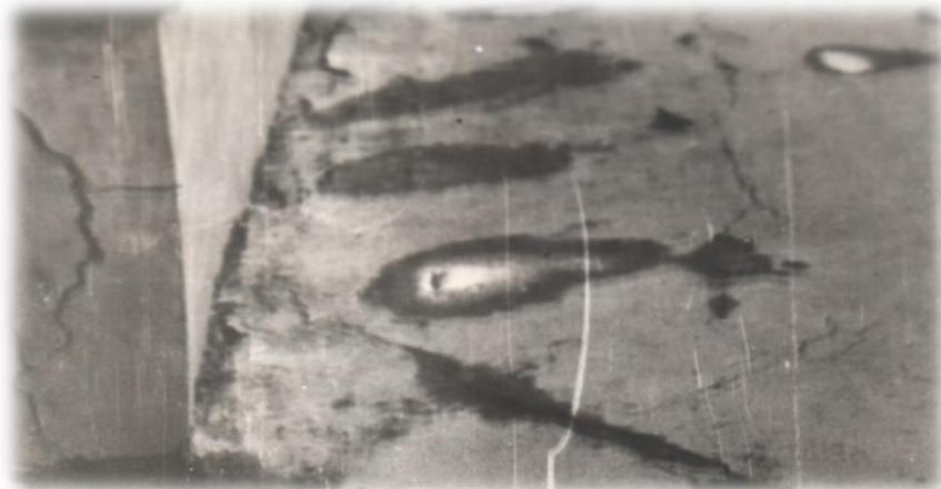
Рис.1 Трещины, образовавшиеся в цокольной части здания
